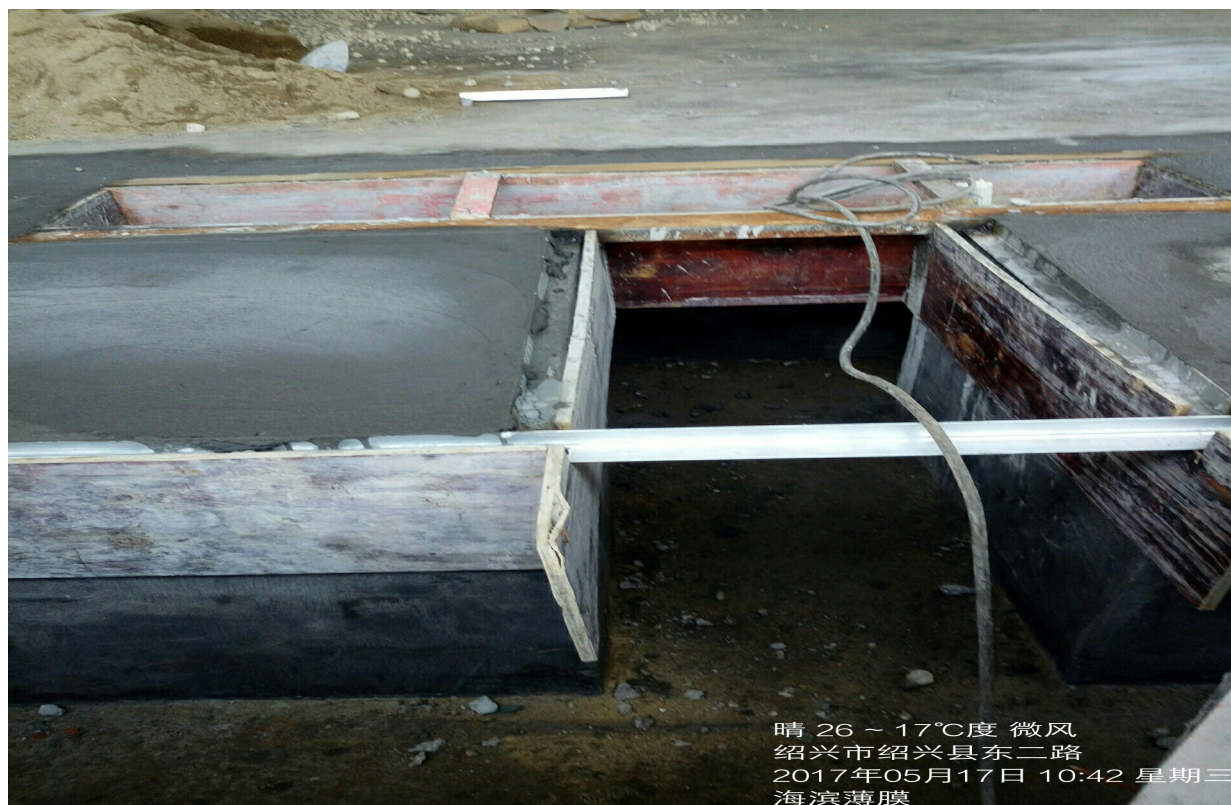
箱变逆变基础浇筑现场：
