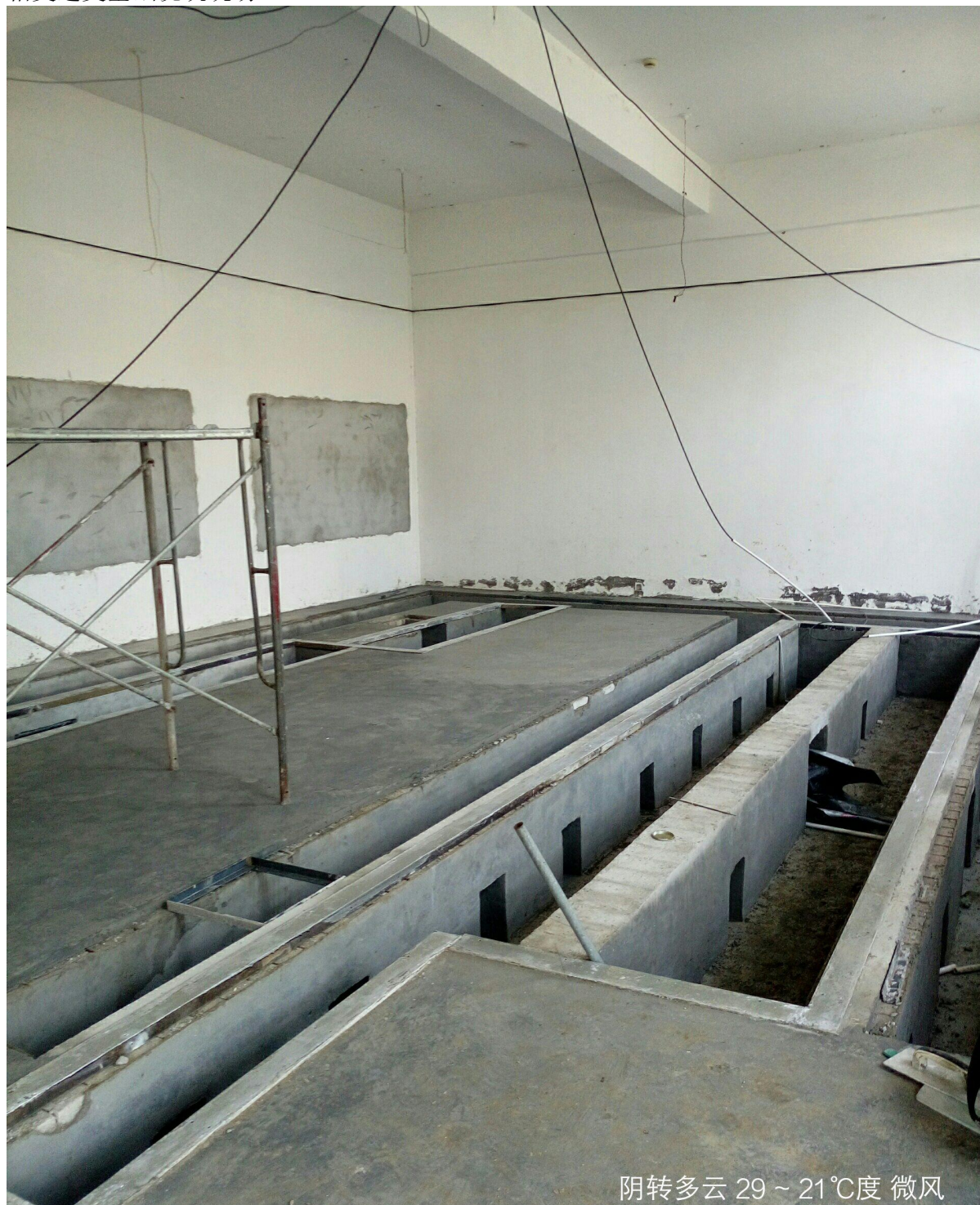
箱变逆变基础浇筑现场：
