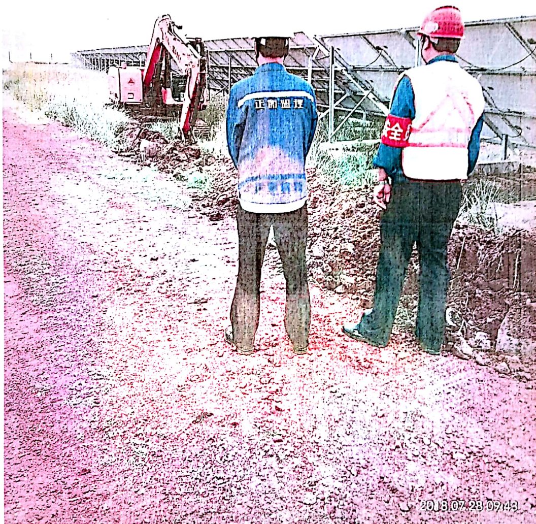
新增光伏组串接地沟开挖监理旁站
