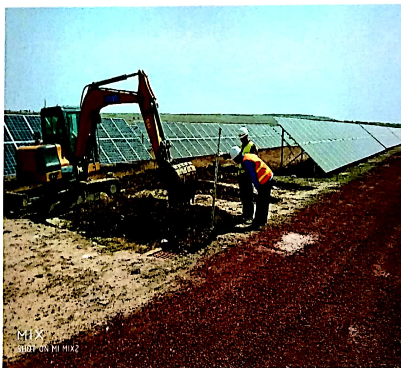
小型机械施工监理现场旁站
