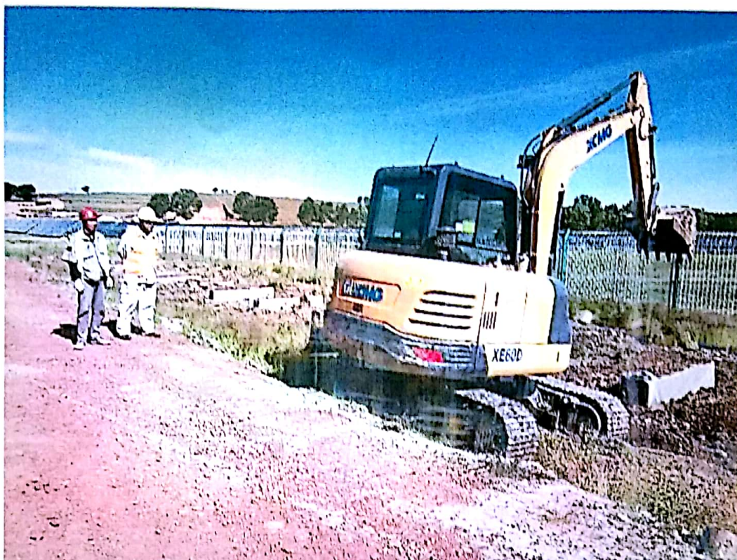
新增光伏支架基础（条形支墩）浇筑后四周土方回填（挖掘机）
