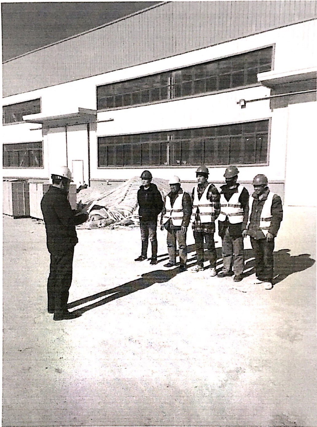
监理项目部负责人对施工人员进行吊装安全技术交底
