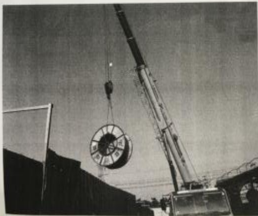
材料区电缆卸、吊装
