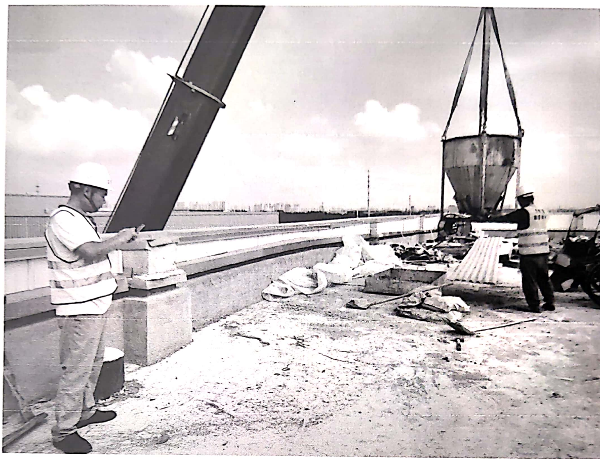
监理旁站照片：
