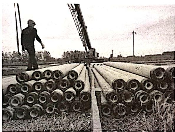
1. 本工程所用的管材为预应力混凝土管，其外径为Φ1200mm，壁厚为100mm，每根管材的重量约为25吨。管材在运输过程中必须小心，避免碰撞和损坏。
