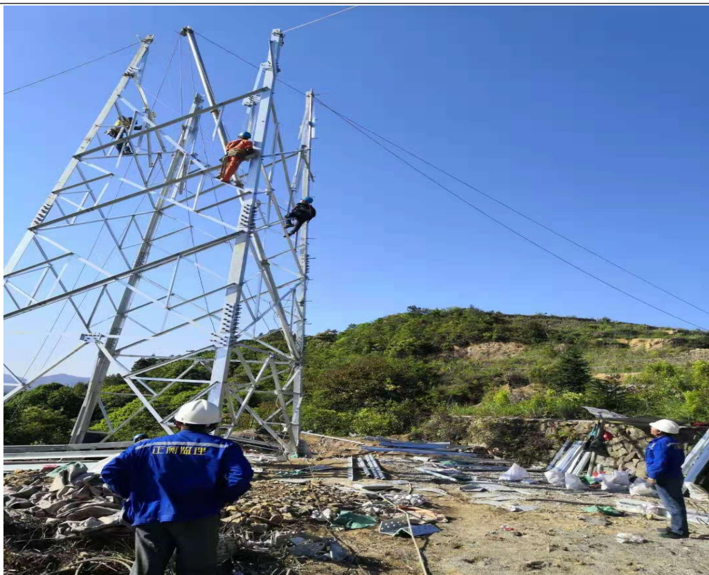
对乌泥塘龙须区 C1 塔组立安装进行安全旁站
