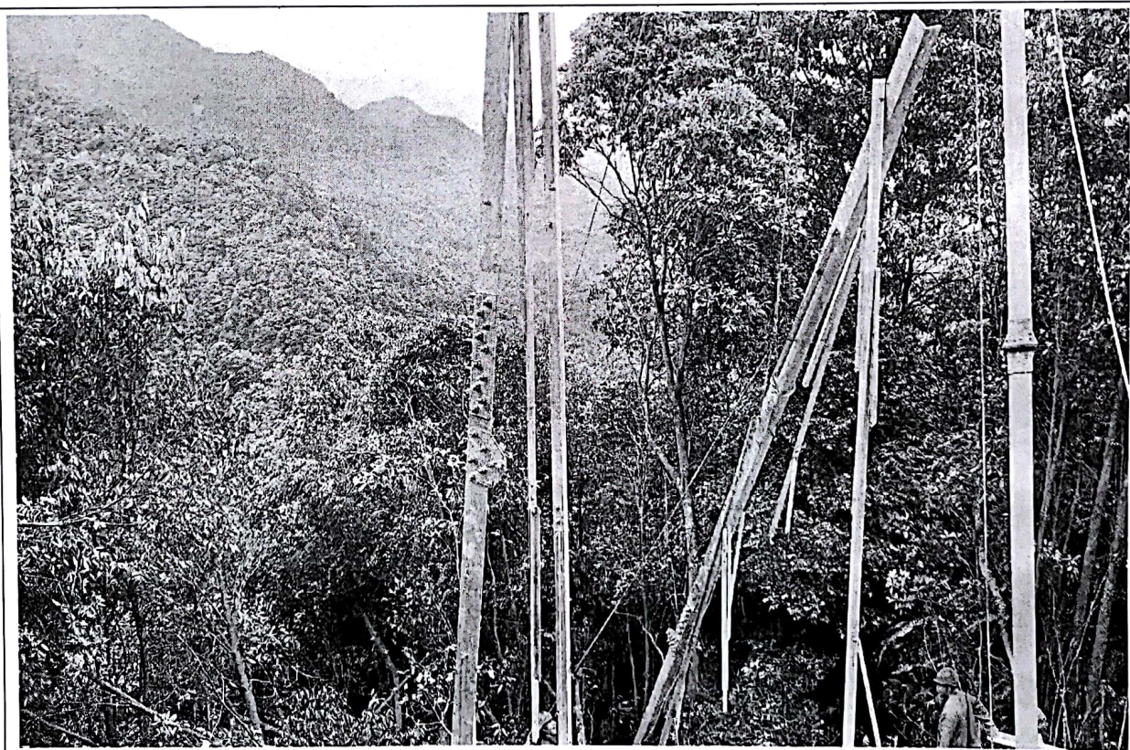
对乌泥塘龙须区 C3 塔组立安装进行安全旁站
