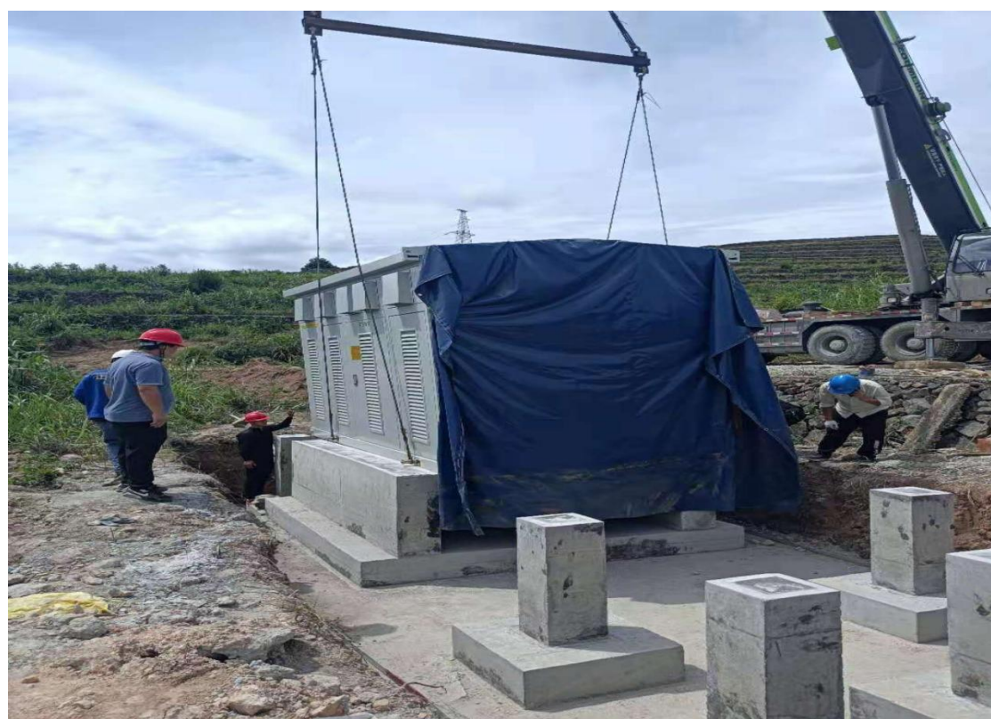
对龙须区 S3、S4 箱变设备吊装就位进行安全旁站
