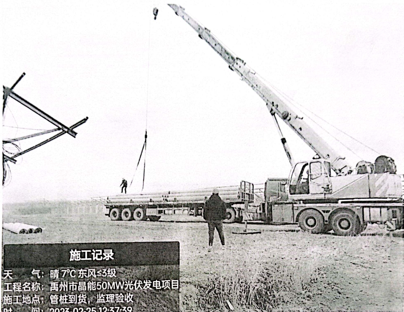
预制管桩进场吊卸
