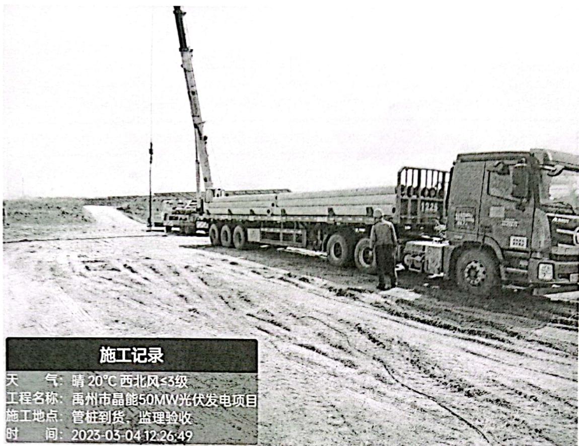
预制管桩进场吊卸
