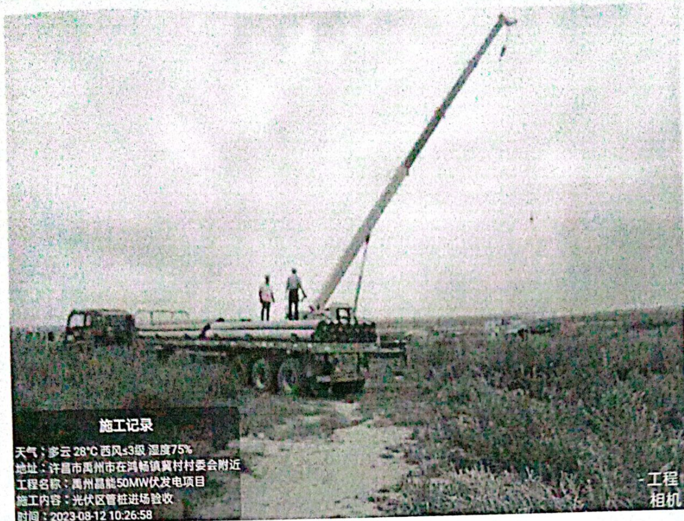
预制管桩进场吊卸
