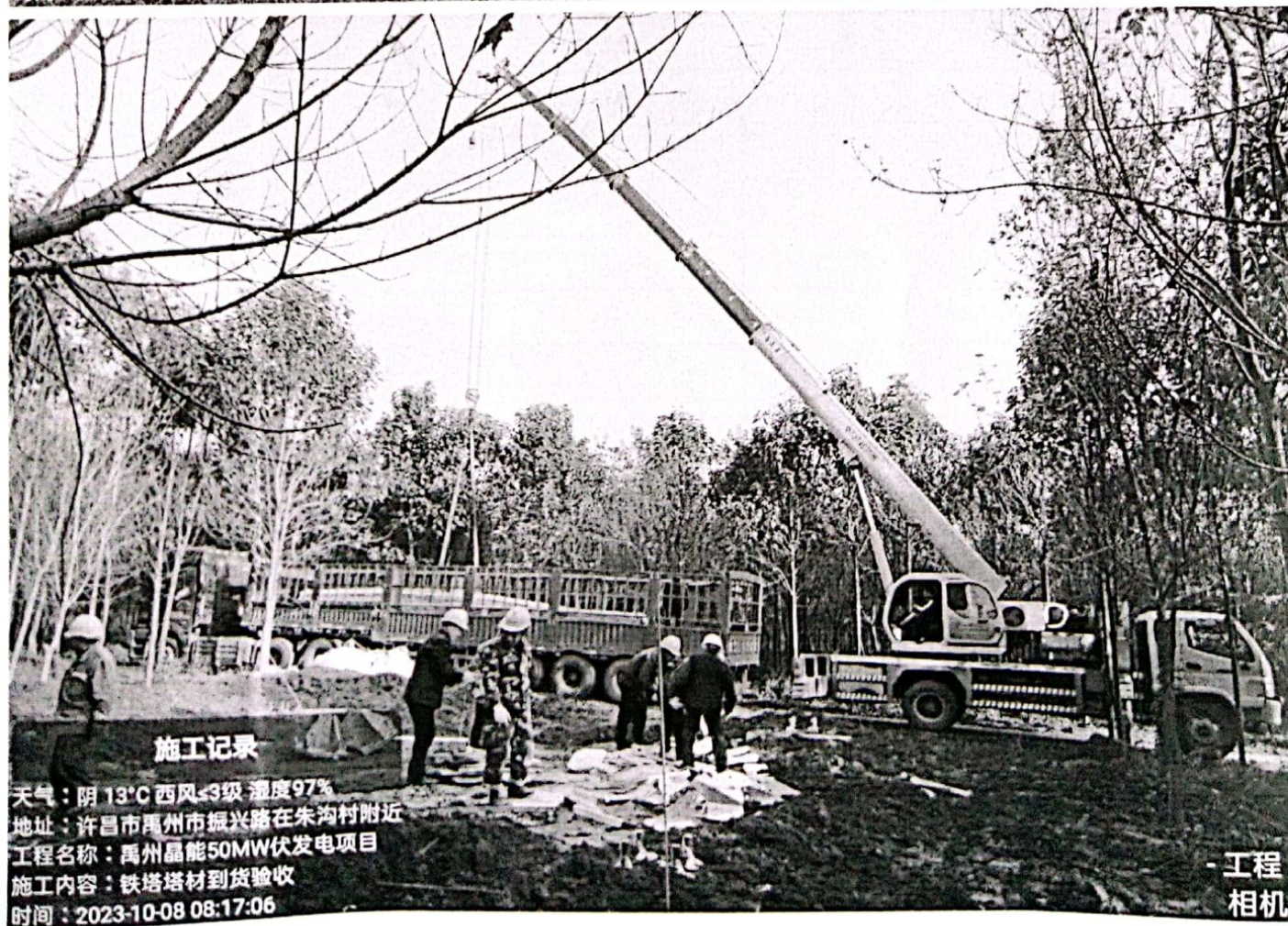
铁塔材料进场吊卸
