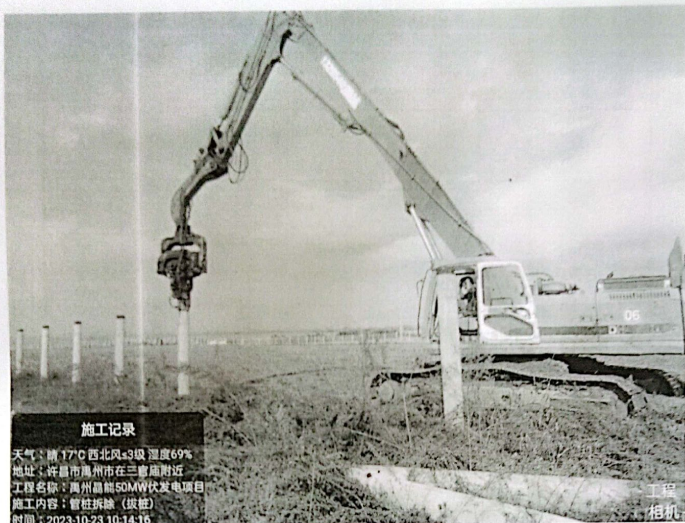
11#光伏区拔桩作业
