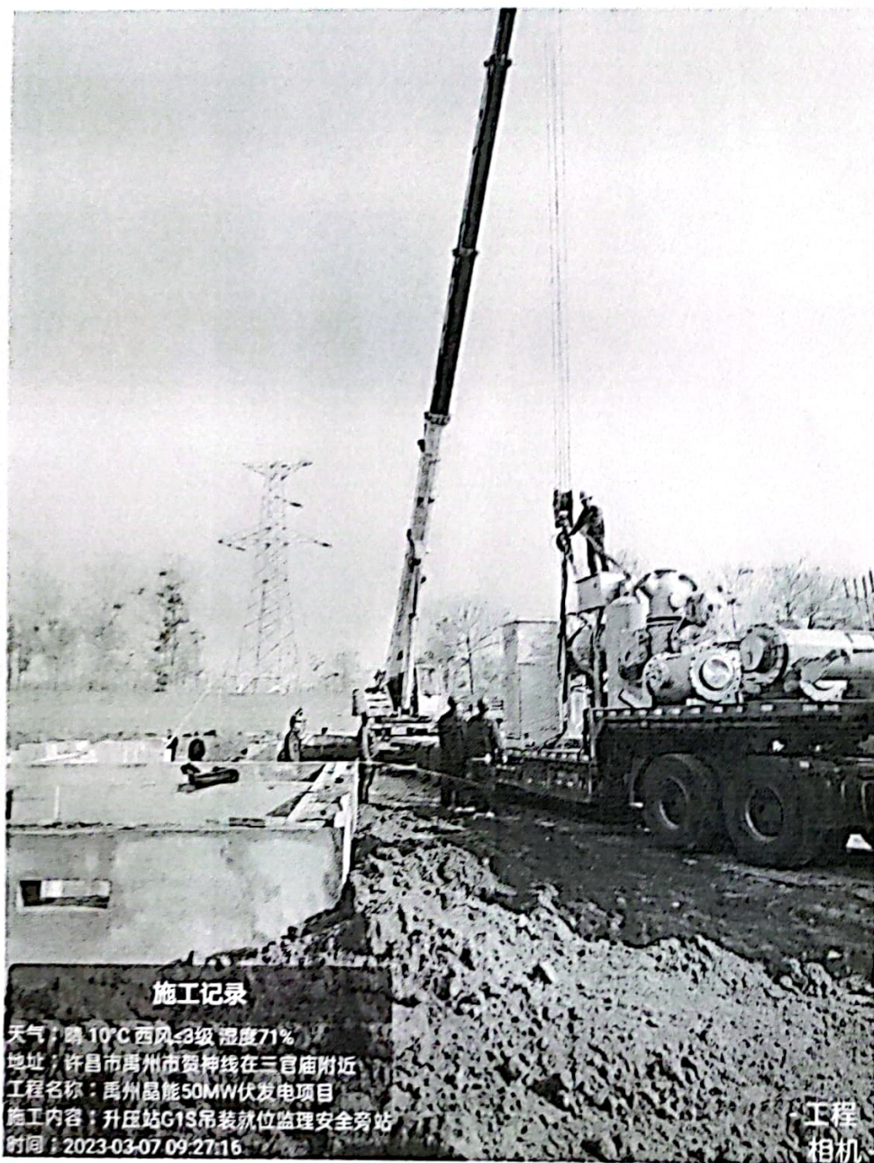
GIS 设备吊装就位监理安全旁站
