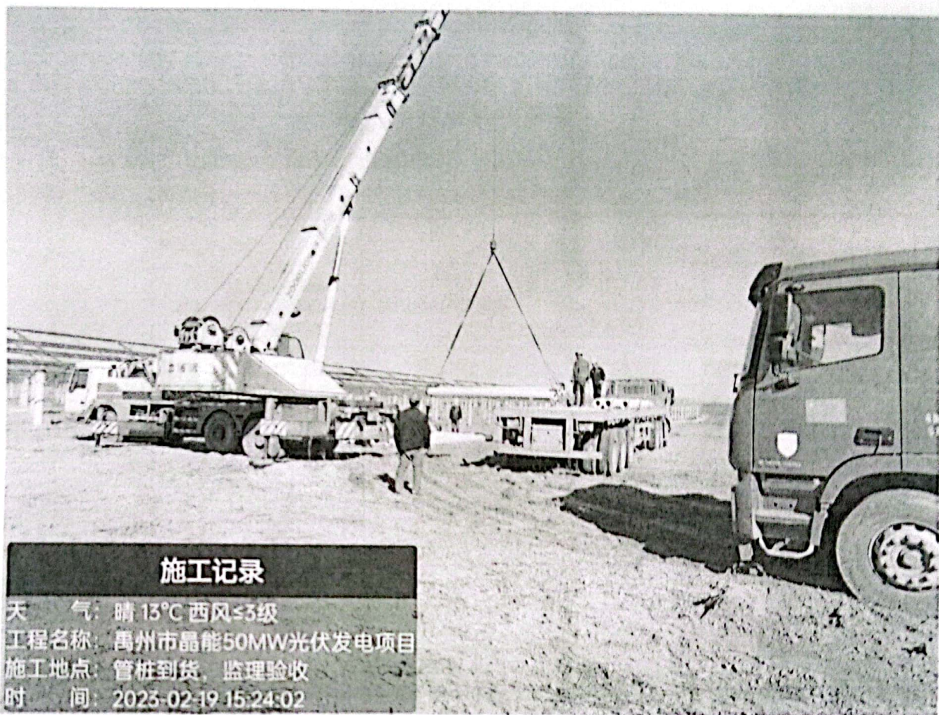
预制管桩进场吊卸
