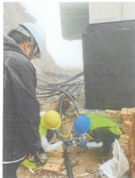
监理人员一直在现场旁站至施工结束，电缆头制作时工序正确，电缆芯线相色分清，排列整齐，线头压接牢固，安装工艺合格。
