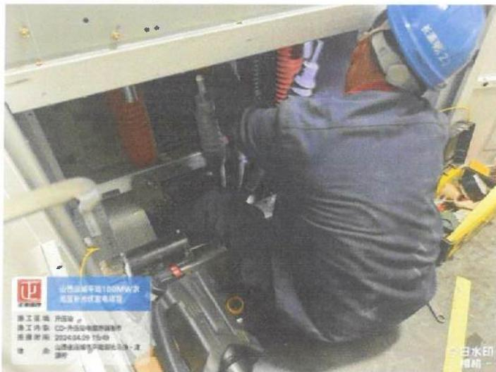
监理人员一直在现场旁站至施工结束，电缆头制作时工序正确，操作符合 35KV 电缆冷缩终端安装工艺指导书，电缆芯线相色分清，排列整齐，线头压接牢固，安装工艺合格。
