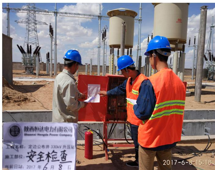
对配电箱接线，配电箱接地，三相五线制检查，检查配电箱灭火器配置以及配电箱检查记录填写情况。
