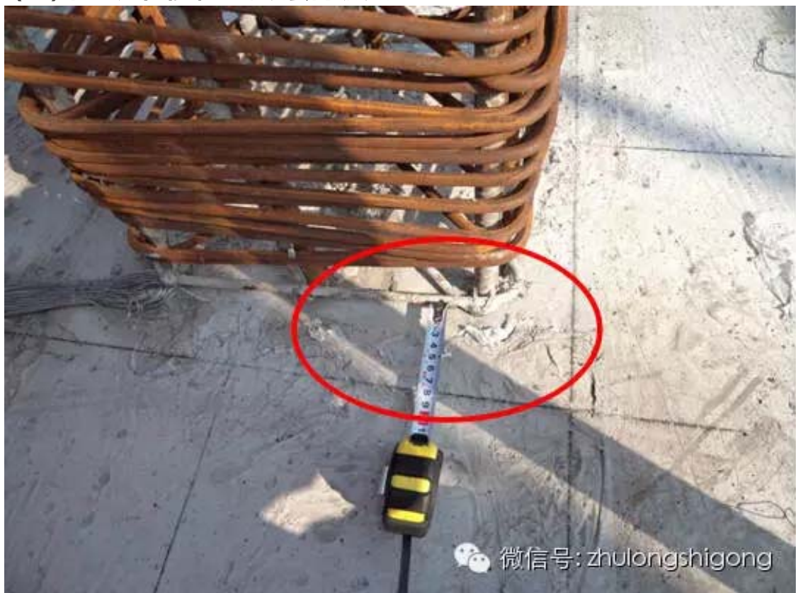
(2) 柱主筋位移，直螺纹套筒破裂。
