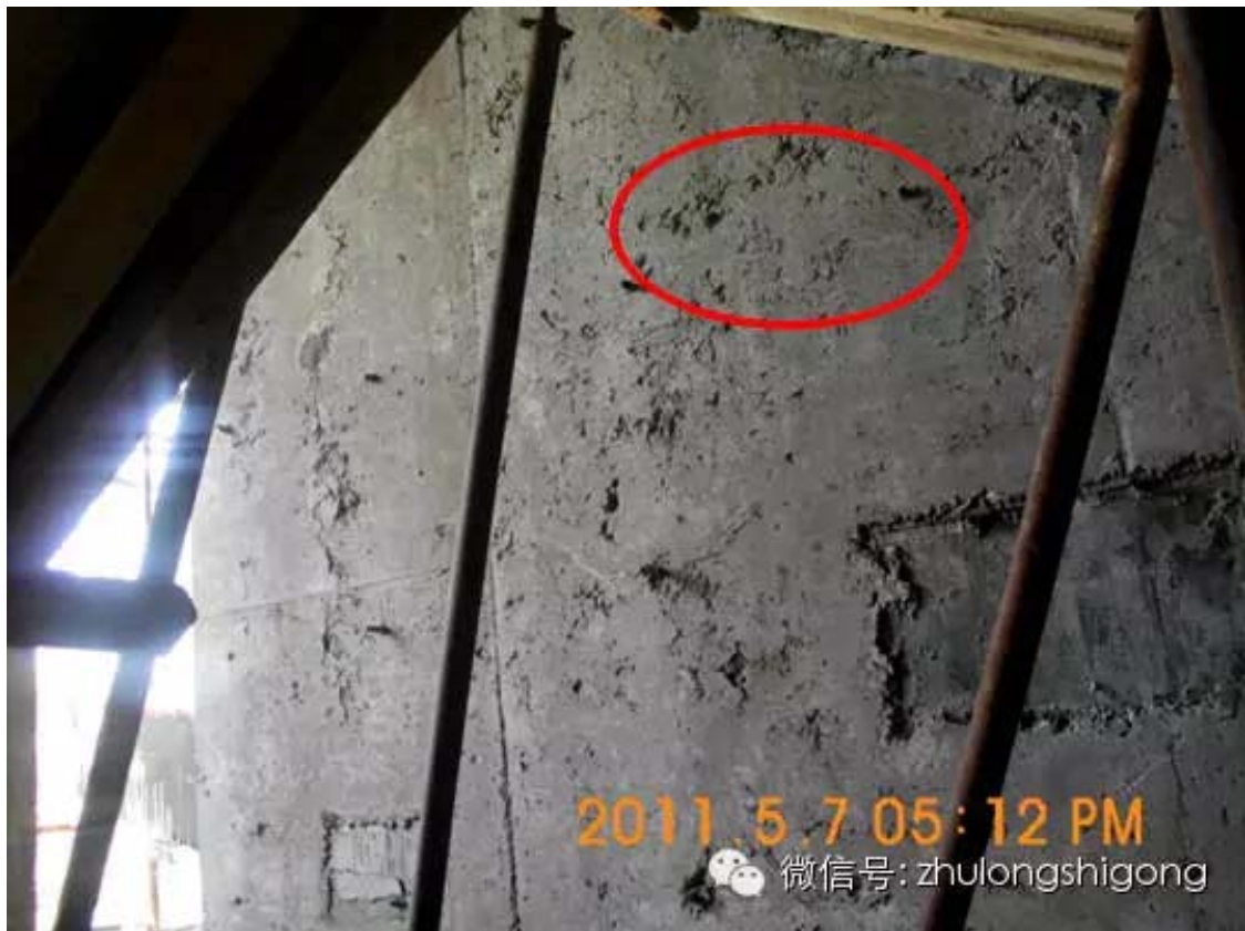
( 12 ) 外表缺陷：构件表面麻面、掉皮、起砂、沾污等，即漏浆等
