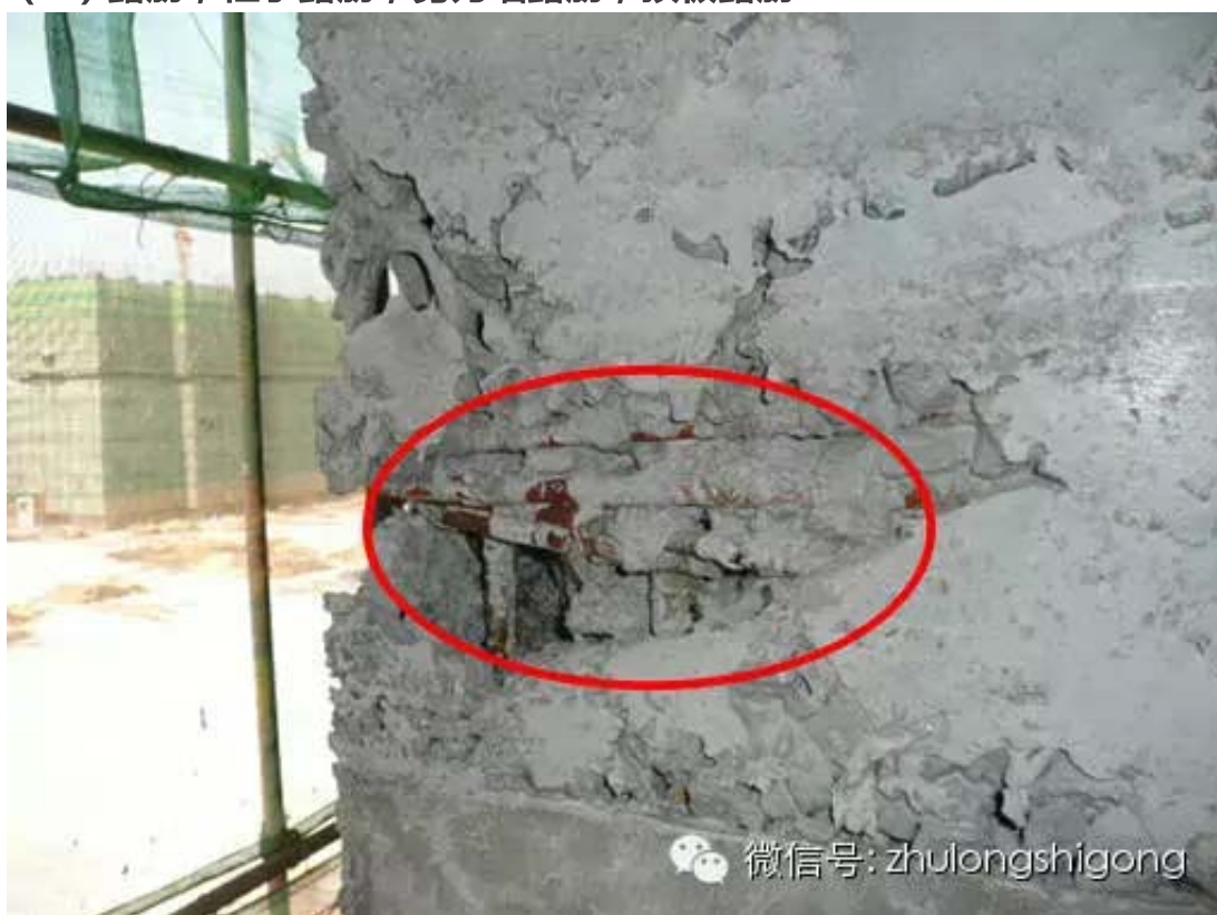
(2) 露筋，柱子露筋，剪力墙露筋，顶板露筋
