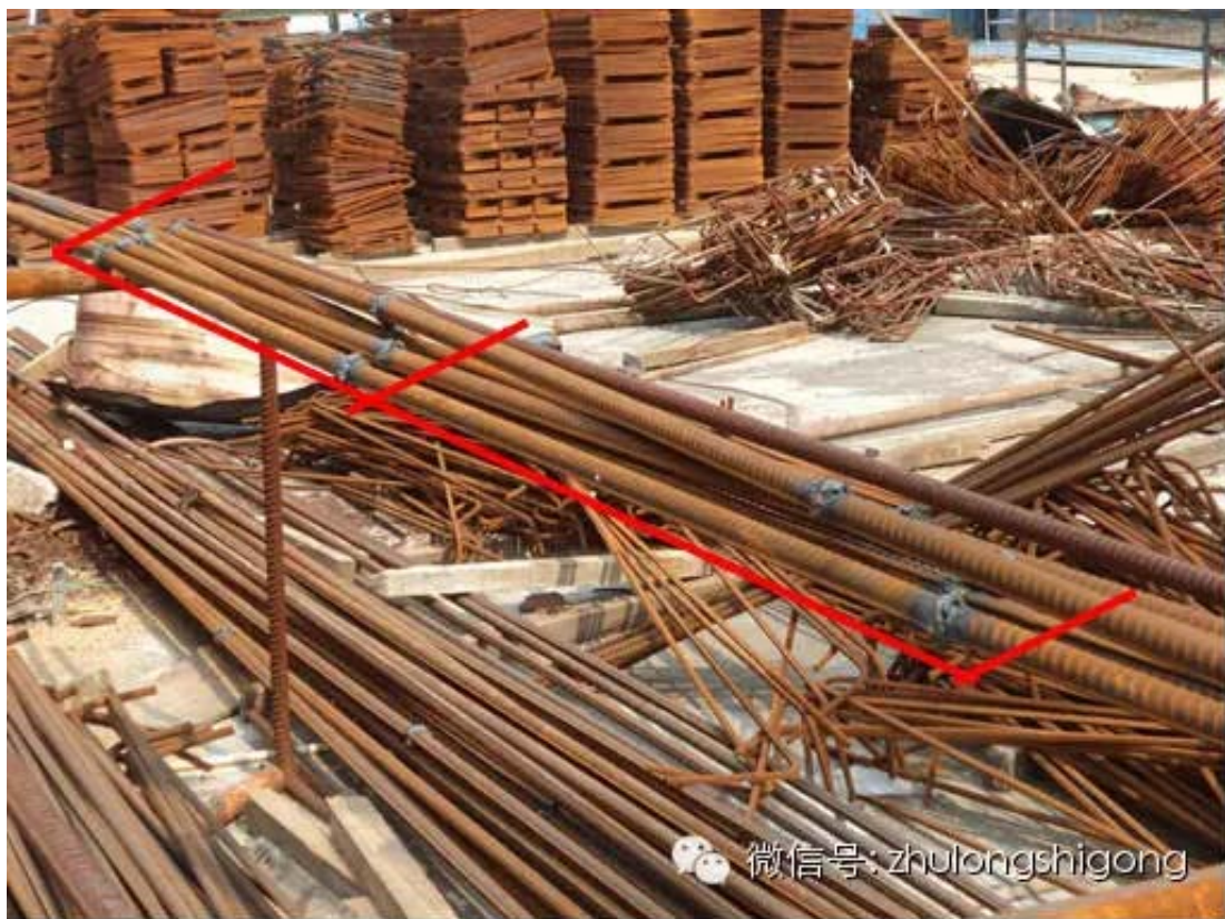
(2) 柱主筋位移，直螺纹套筒破裂。
