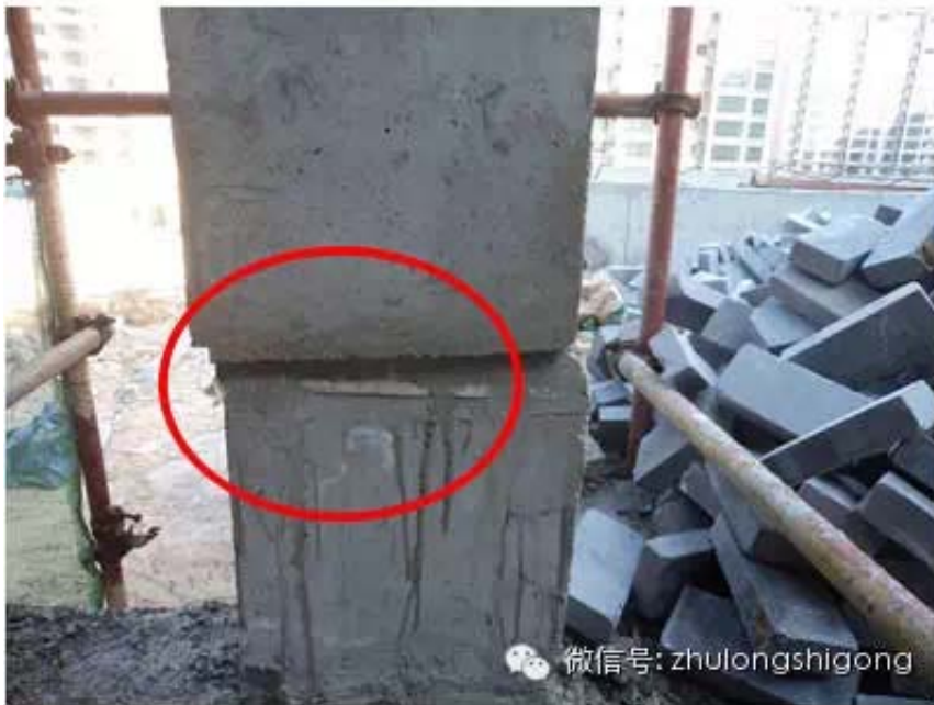
(8) 连接部位缺陷2：连接钢筋松动。
