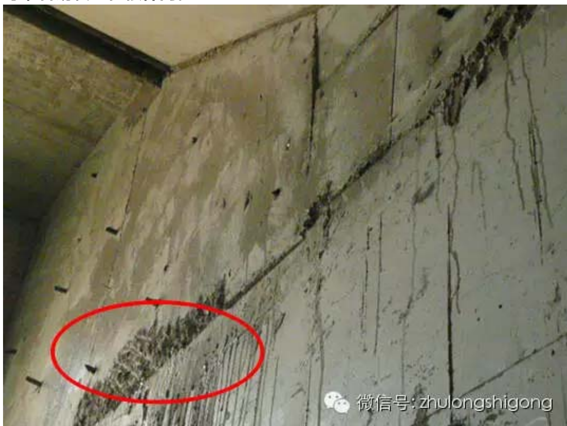
( 10 ) 外形缺陷2：缺棱掉角、棱角不直、翘曲不平、飞边凸肋，即胀模等，容易发生在楼梯间。
