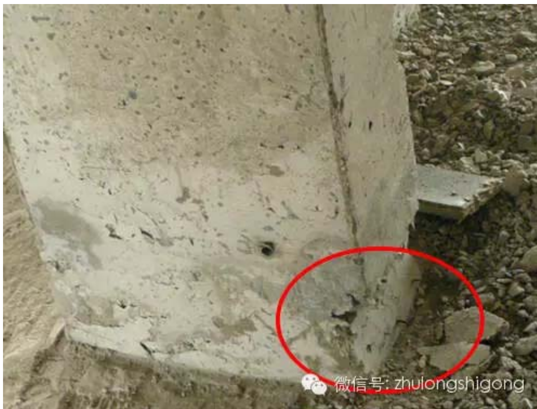
( 10 ) 外形缺陷2：缺棱掉角、棱角不直、翘曲不平、飞边凸肋，即胀模等，容易发生在楼梯间。
