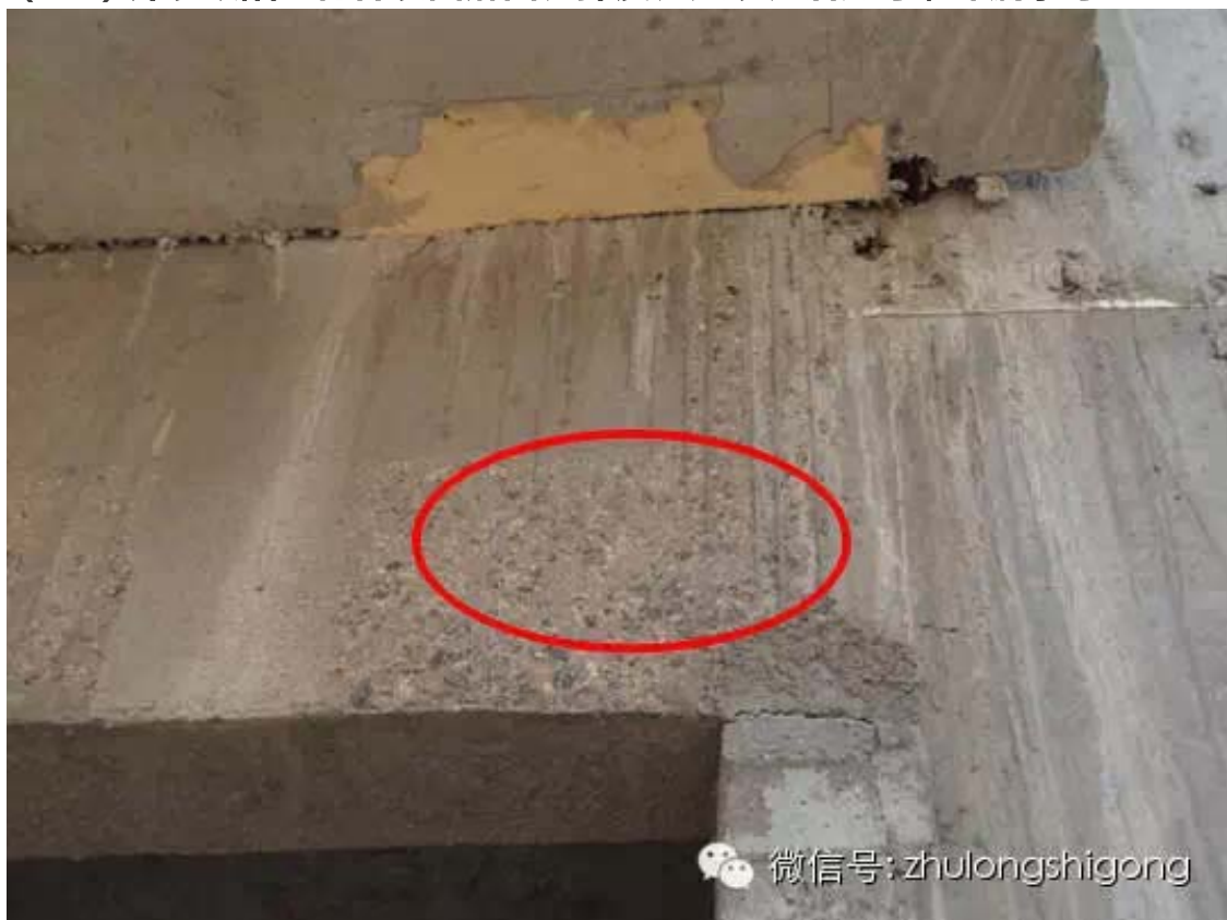
( 11 ) 外表缺陷：构件表面麻面、掉皮、起砂、沾污等，即漏浆等
