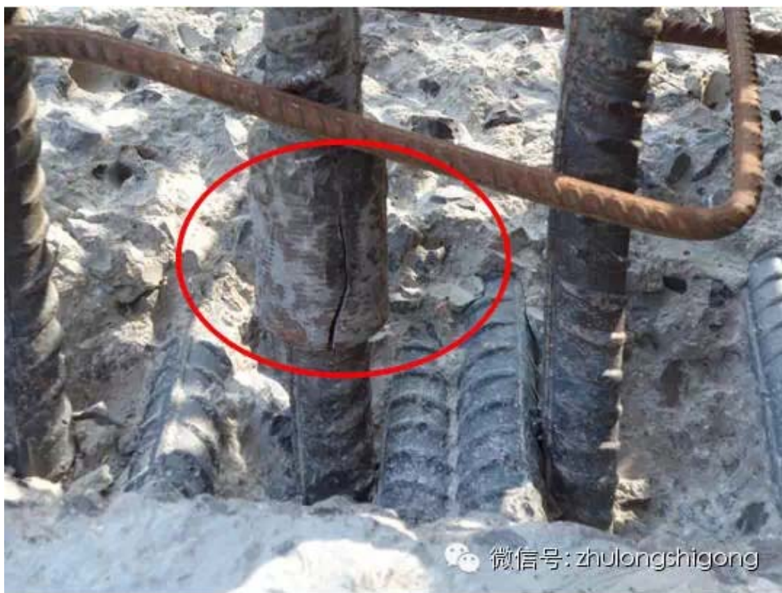
(9) 外形缺陷1：缺棱掉角、棱角不直、翘曲不平、飞边凸肋，即胀模等，容易发生在楼梯间。
