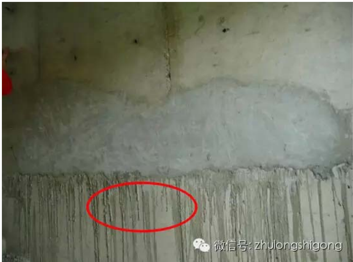
( 12 ) 外表缺陷：构件表面麻面、掉皮、起砂、沾污等，即漏浆等
