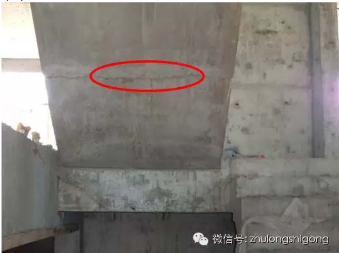
(8) 连接部位缺陷2：连接钢筋松动。
