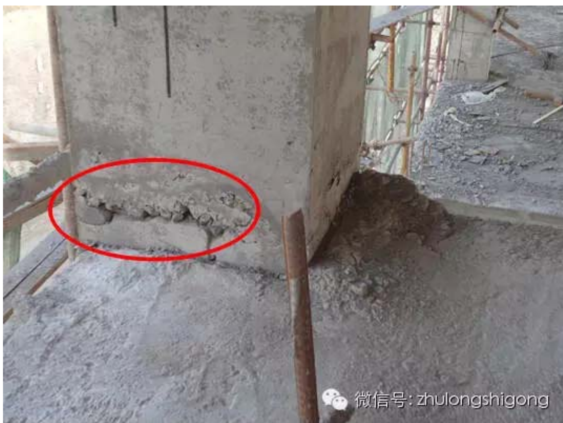
(4) 孔洞 (墙、柱、后浇带)
