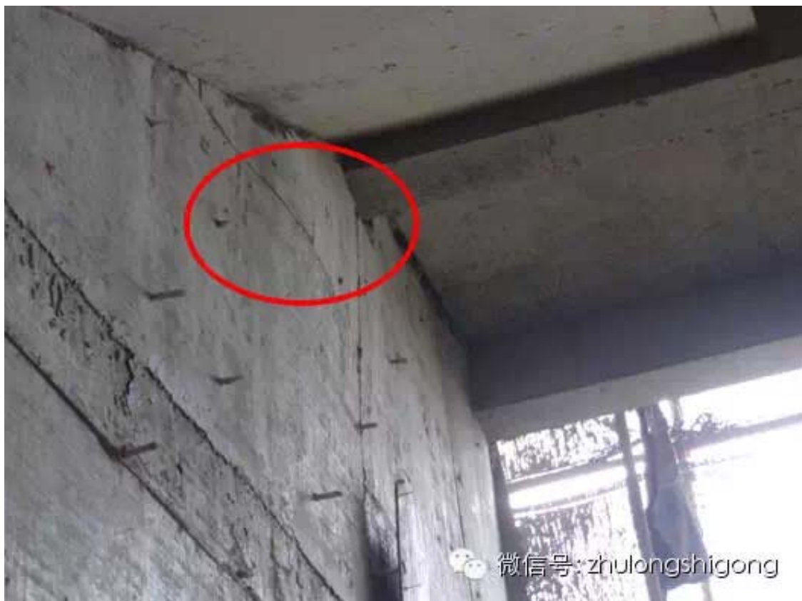
( 11 ) 外表缺陷：构件表面麻面、掉皮、起砂、沾污等，即漏浆等
