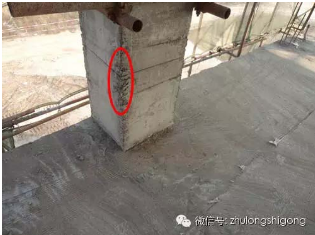
(9) 外形缺陷1：缺棱掉角、棱角不直、翘曲不平、飞边凸肋，即胀模等，容易发生在楼梯间。
